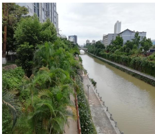
项目南面现状
