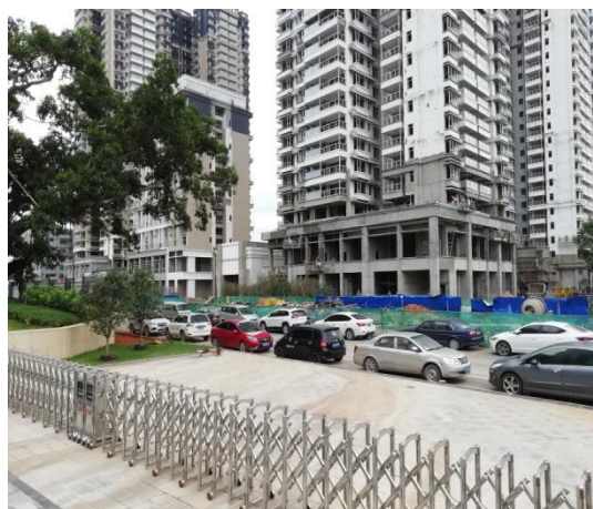
项目东面现状
